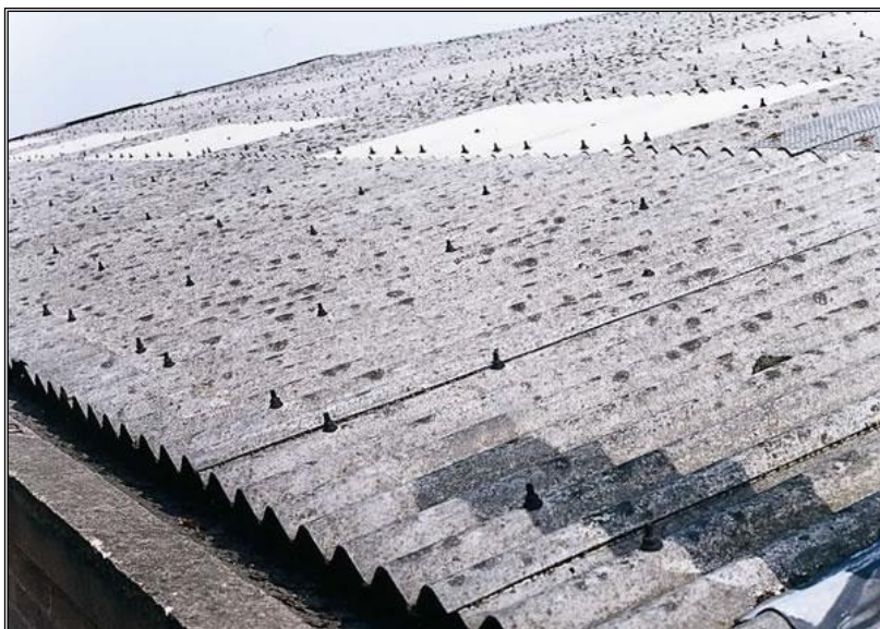
Rysunek 1. Dach pokryty azbestową płytą falistą
