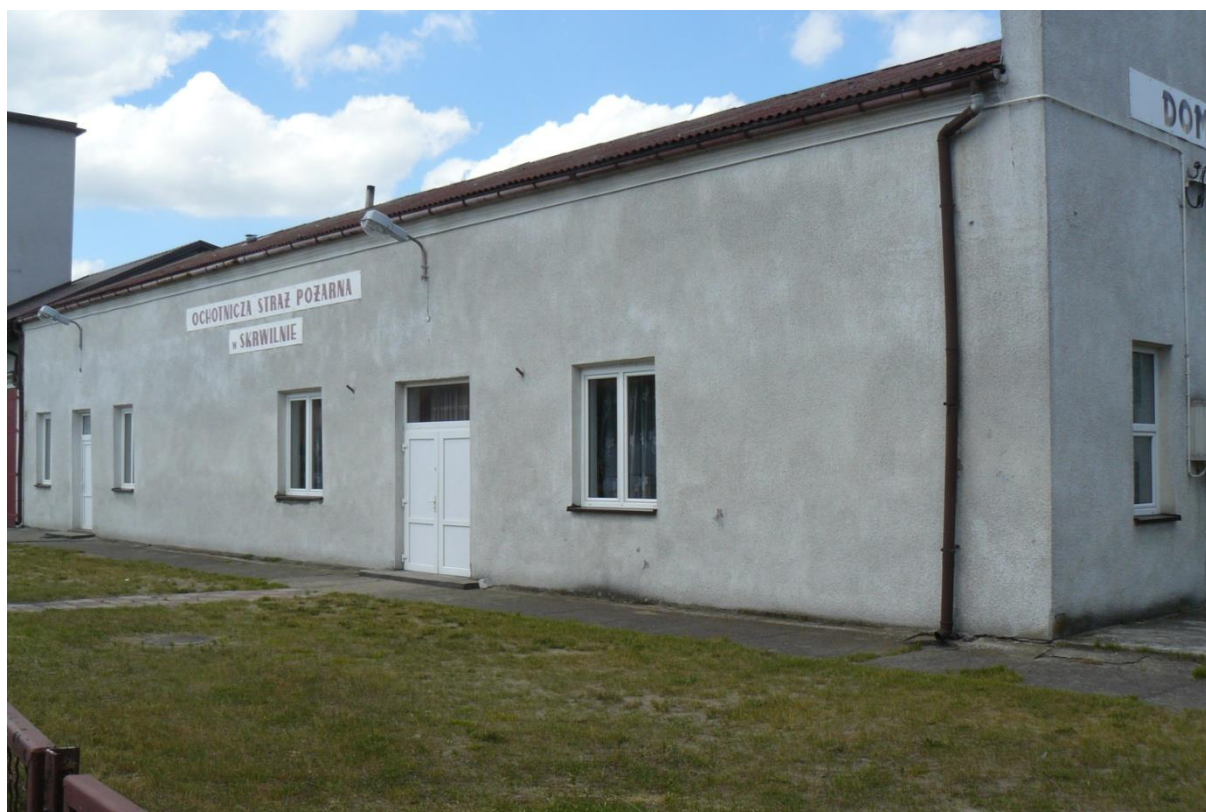
Fotografia 3. Świetlica wiejska w miejscowości Skrwilno.
